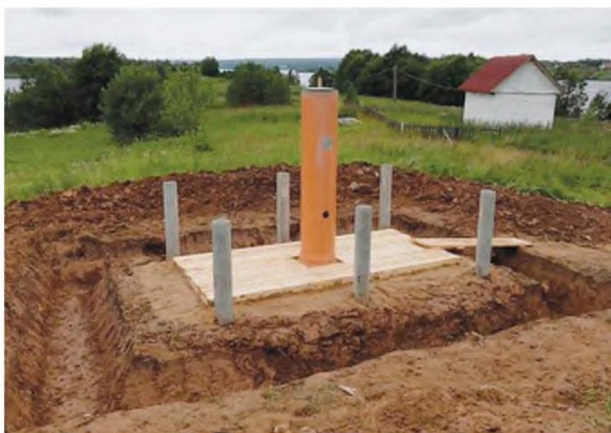
Рис. 13. Центр пункта ГНСС-наблюдений на комплексной геомагнитной обсерватории «Климовская» [7]
